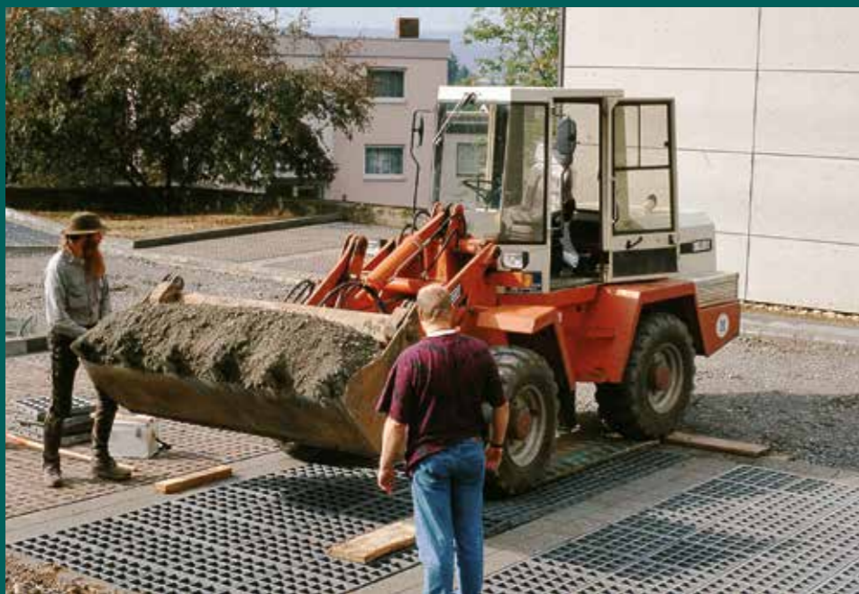
Fugenverfüllung nach dem Verlegen auf 2-3 cm Ausgleichsschicht
