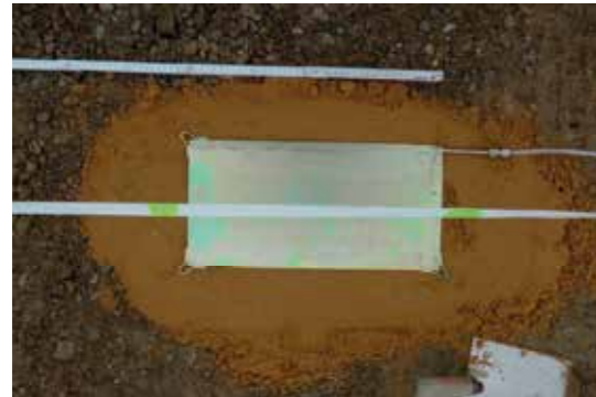
Bild 2: Messdose auf verbessertem Bodenplanum, vor Einbau der Vegetationstragschicht
