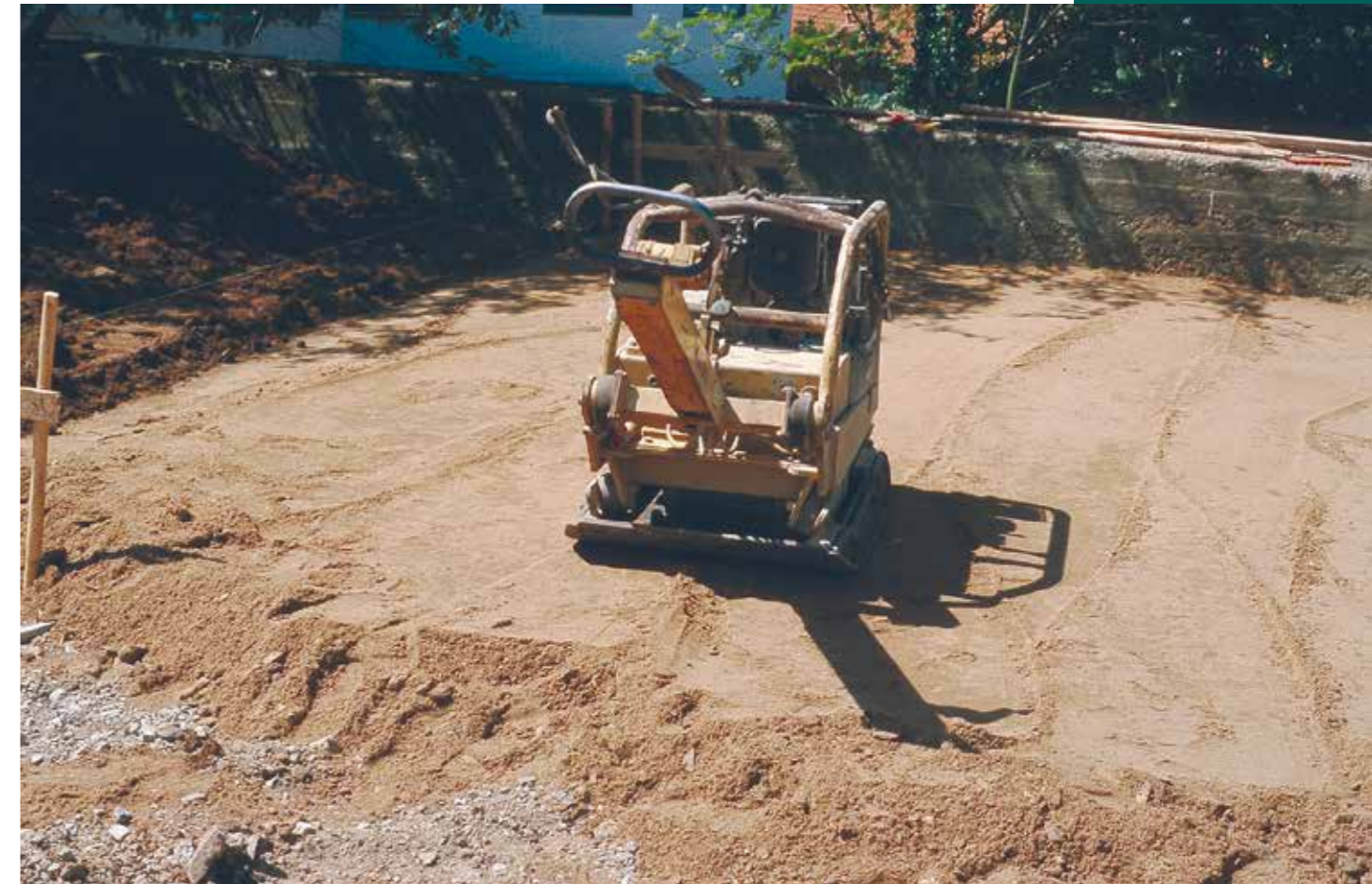
Einbau eines nicht bindigen Untergrundmaterials auf der Versuchsfläche.
